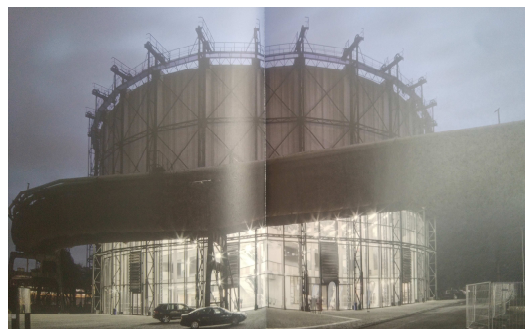
obr. 11 Pohled na plynojem
