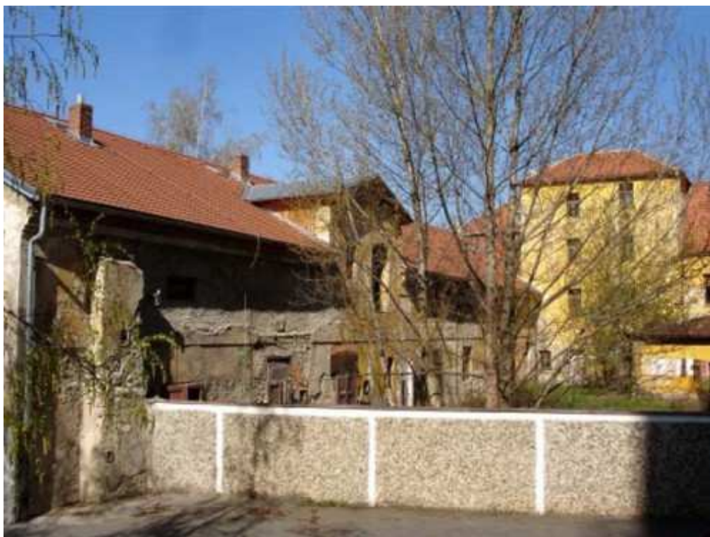
obr. 8 - Dominikánský dvůr v Braníku: Zdroj: [online] 2018 risv.cz [cit. 2019-03-20] dostupné z http://www.risv.cz/cs/vyhledavace/brownfields/detail?id=9021
