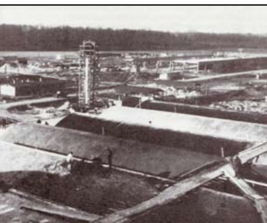
Výstavba nového závodu LET Kunovice
