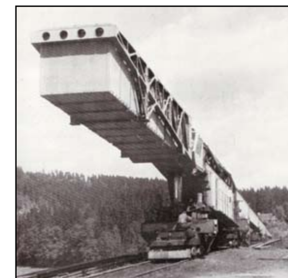
Hydraulický jeřáb HKJ 35 k osazování mostních polí
