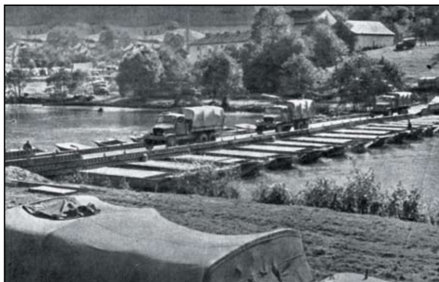
Most sestavený z části střední mostové soupravy
