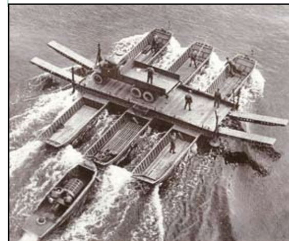
Přívozové soulodí sestavené z dílů střední mostové soupravy
