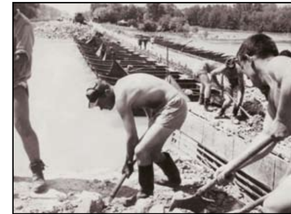
Budování protipovodňové hráze u Medveďova
