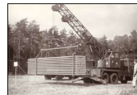
Pokládka polního potrubí pro dopravu PHM
