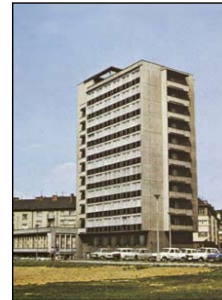
Hotelový dům Škoda – Plzeň vybudovaný v letech 1963–1964
