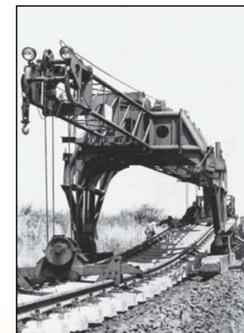
Pokládka železniční tratě s pomocí nemodernější techniky
