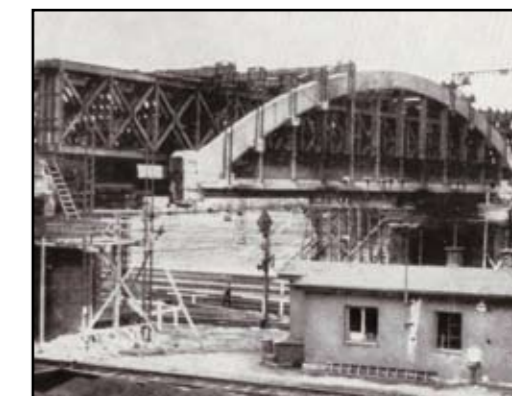
Unikátní snesení mostu nad zhlavím železniční stanice v České Třebové
