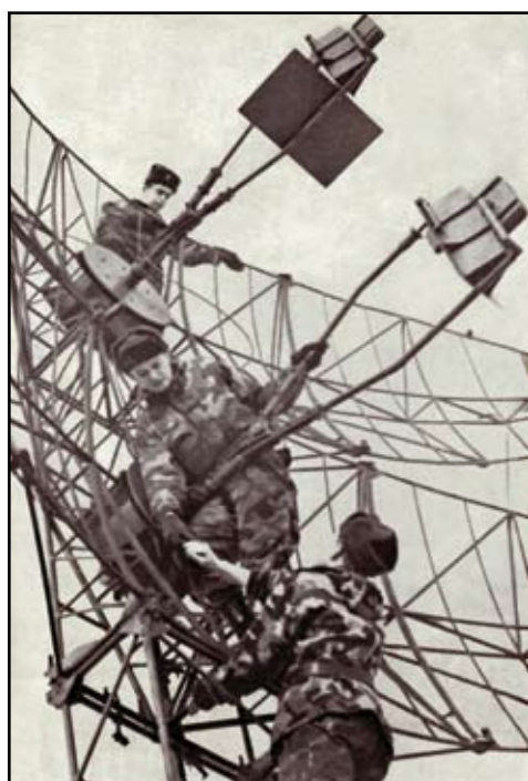
Oprava anténního systému radiolokátoru P-14
