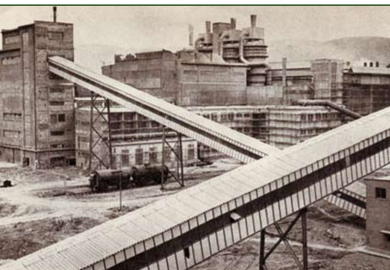
Významná „stavba socialismu“ hliníkárna v Žiaru nad Hronom
