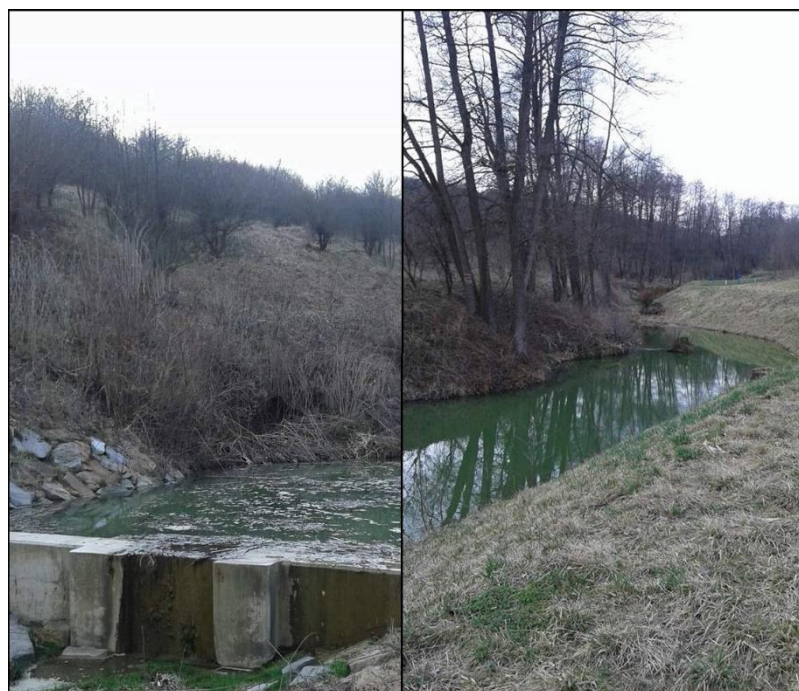
Obrázek 9: Hráz a nádrž na potoce Hořenišek
