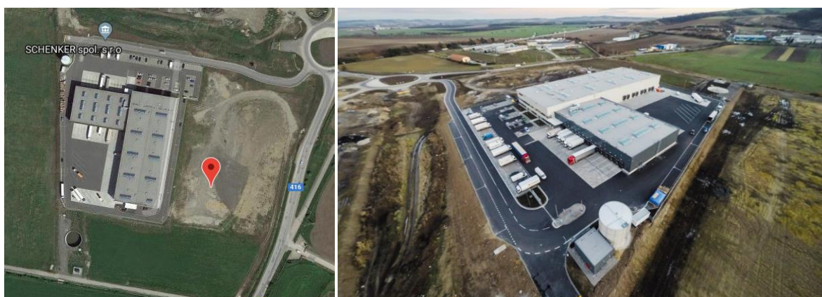
Průmyslová hala u obce Blučina (satelitní snímek a fotografie objektu)
