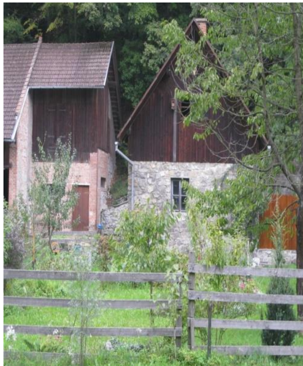
Obr. 32. Detail pracovní části hamru ( foto autor ).
