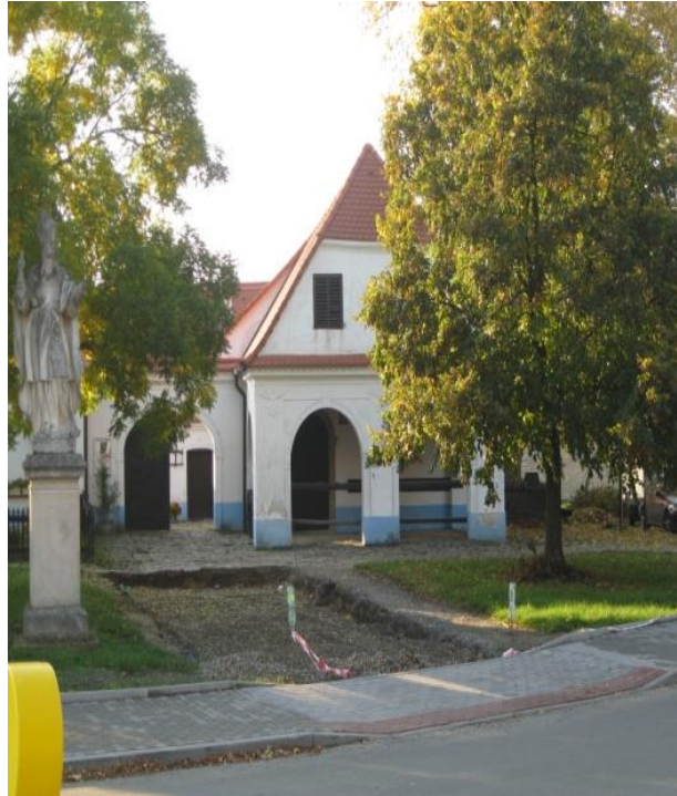
Obr. 14. Celkový pohled na kovárnu. ( foto autor ).
