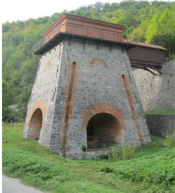
Obr. 7. Vysoká dřevouhelná pec Staré huti. ( foto autor )
