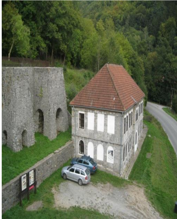
Obr. 21. Objekt bývalé modelárny ( foto autor ).
