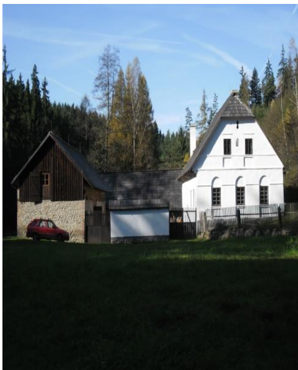
Obr. 33. Celkový pohled na objekt ( foto autor ).
