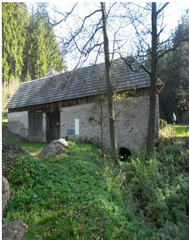
Obr. 36. Odtok vody z náhonu vedoucí pod budovou ( foto autor ).
