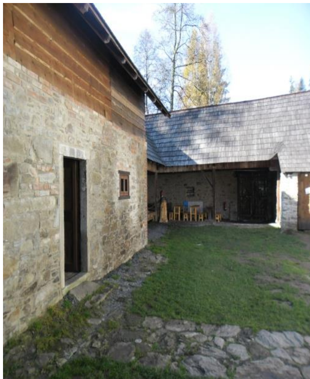
Obr. 38. Skladovací a vstupní budova ze dvora ( foto autor ).
