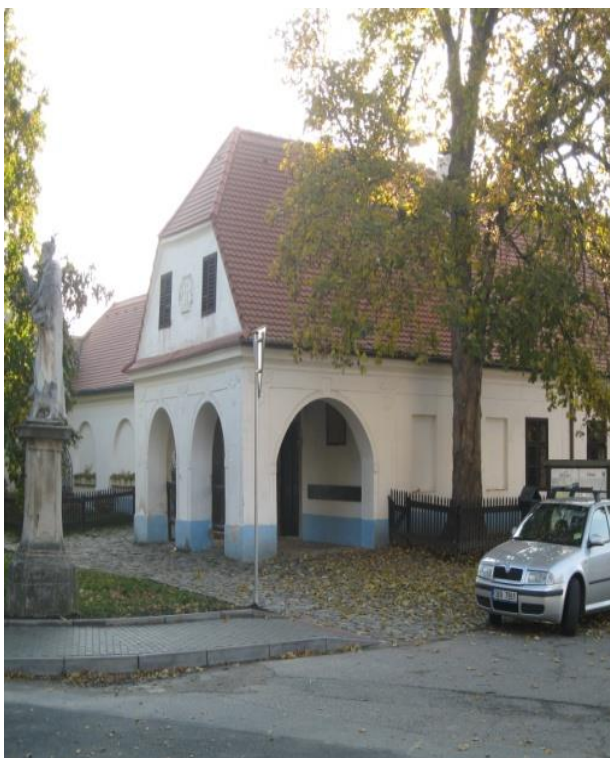
Obr. 43. Celkový pohled na kovárnu ( foto autor ).
