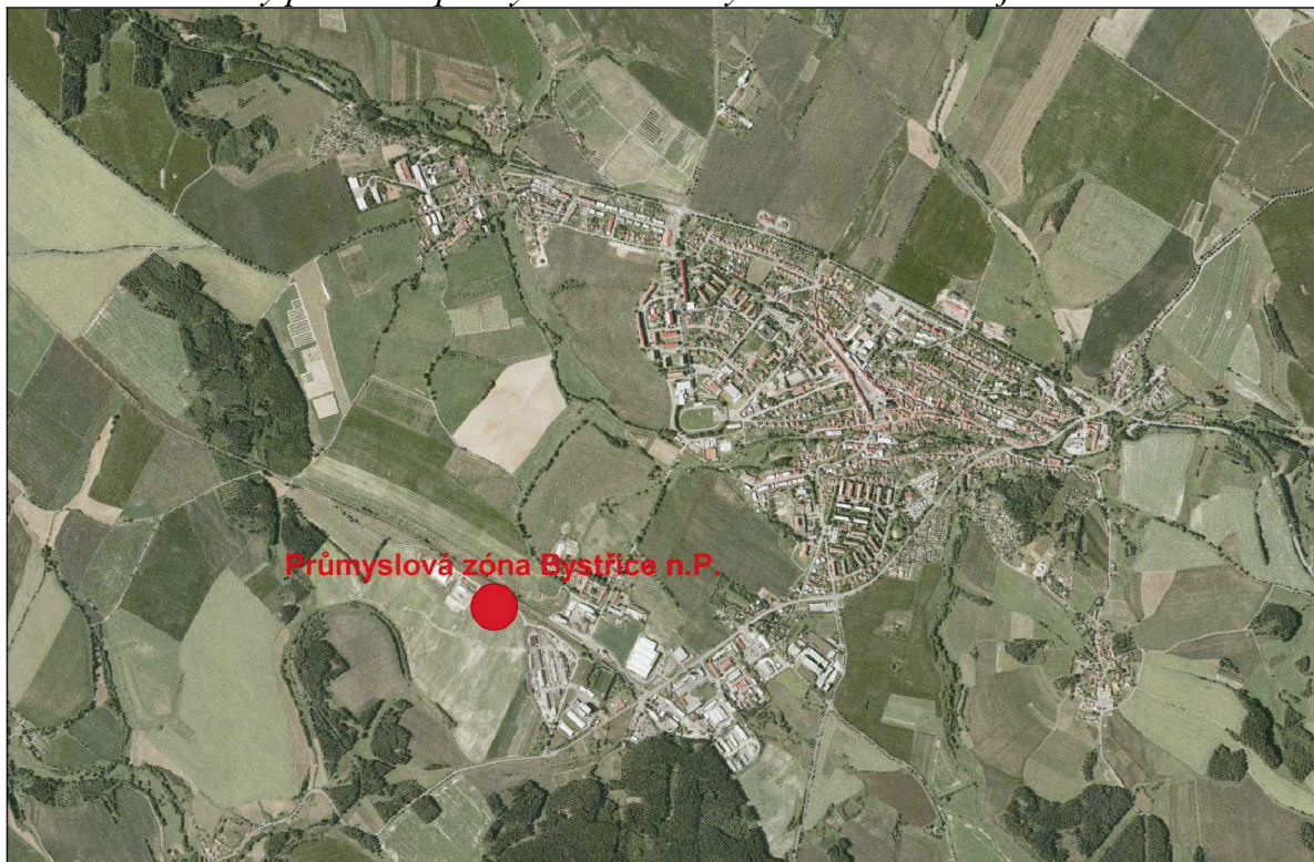
Obr. č. 12: Letecký pohled na průmyslovou zónu Bystřice nad Pernštejnem
