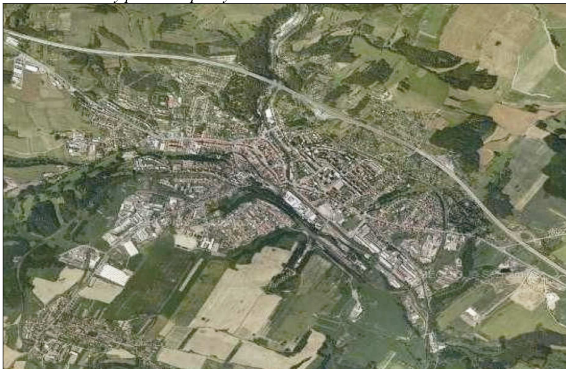
Obr. č. 14: Letecký pohled na průmyslovou zónu Velké Meziříčí
