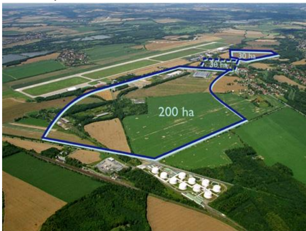
Obr. č. 9: Průmyslová zóna Ostrava - Mošnov
