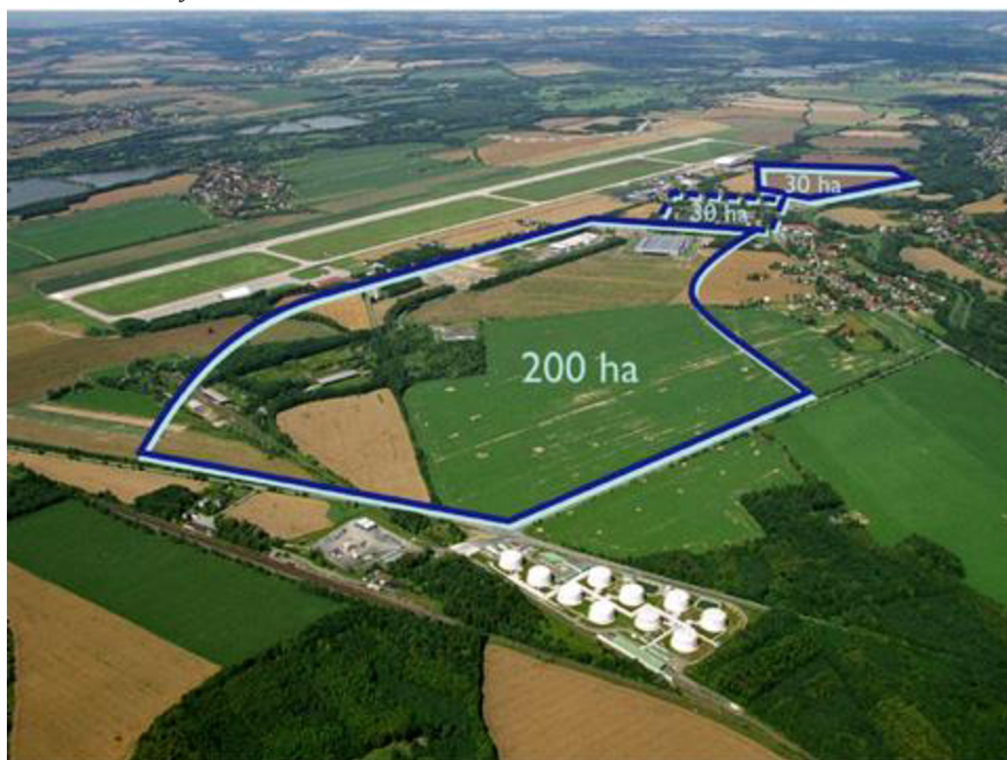
Obr. č. 9: Průmyslová zóna Ostrava - Mošnov
