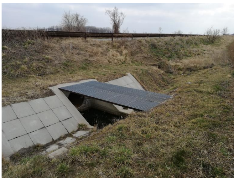
Obr. 3 - Ústí sběrného příkopu do svodného v k.ú. Bantice (v pozadí původní ústí ucpané přívalem bahna)
