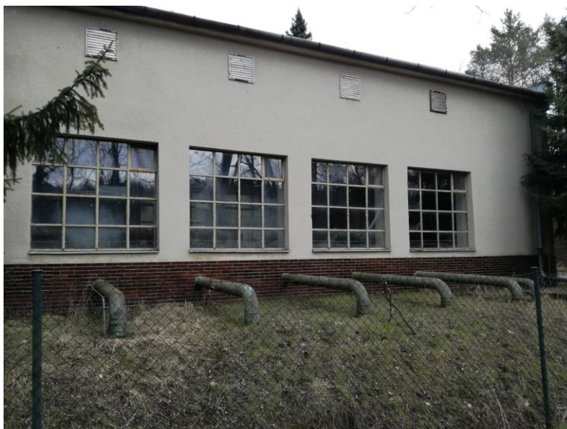
Obr. 5 - Čerpací stanice pod hrází VD Těšetice v k.ú. obce Kyjovice
