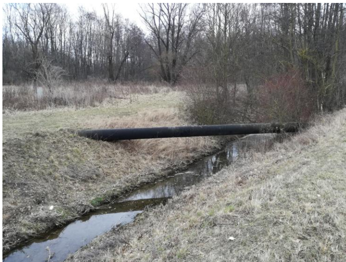
Obr. 1 - Odvodňovací kanál na toku Únanovky + HZZ v k.ú. Kyjovice
