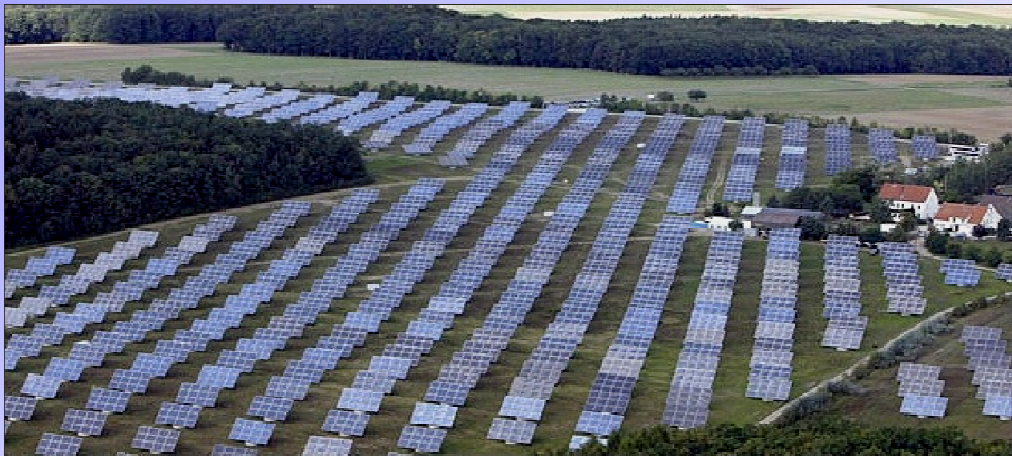
elektrárna využívající solární panely (Bavorsko)
