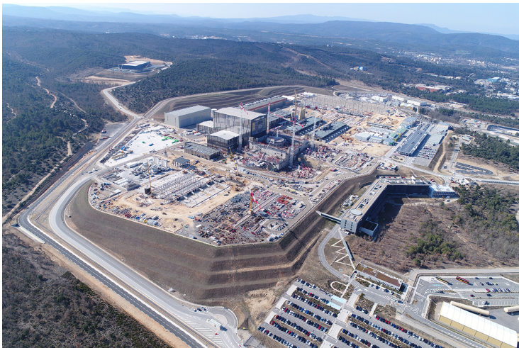
Pohled na stavenišť ITERu v roce 2018. 62
