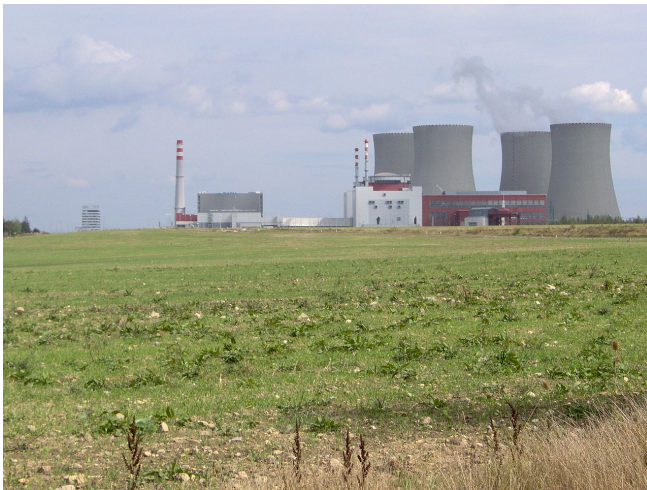
Jaderná elektrárna Temelín. 100
