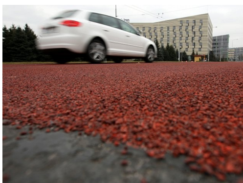
Obrázek 47: Detail brzdňého pásu
