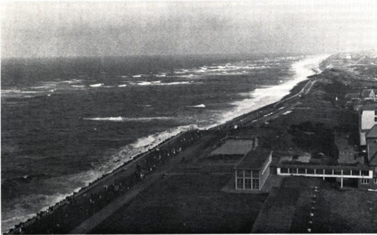
Abb. 2. Uferschutzwerke vor Westerland mit Riff- brandung (Blick vom neuen Kurzentrum nach Norden)
