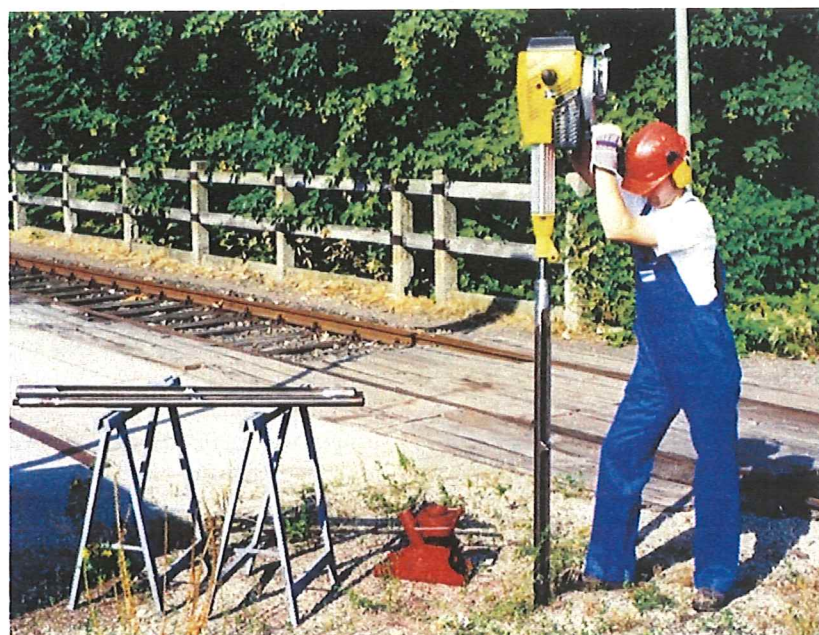
Abb. 2 Häufig verwendet bei Kleinbohrverfahren: tragbares Kleinrammbohrgerät
