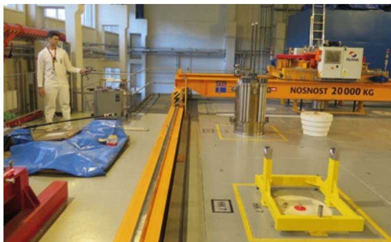
Obr. 8: Pracovníci provedou vysunutí vnitřního hnízda do prostoru komory.
