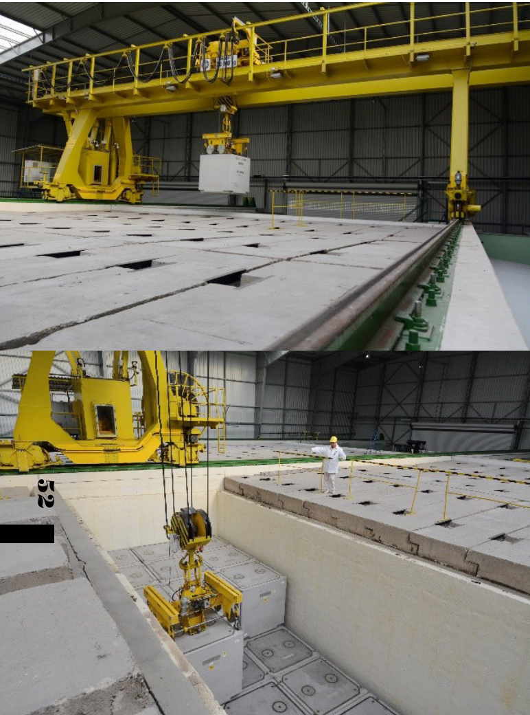
Obr. 4: Ukladanie RAO upraveného zacementovaním vo VBK do úložného boxu Republikového úložiska RAO v Mochovciach
