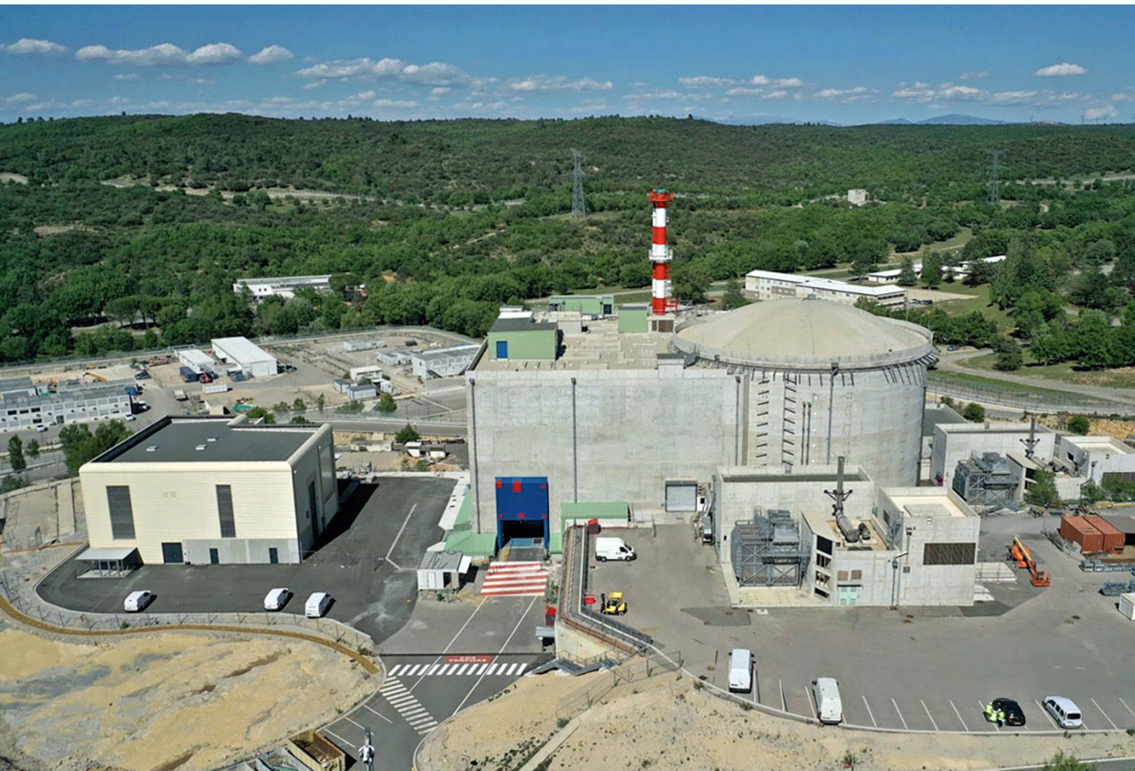
Obr. 1: Pohled na stavbu JHR v roce 2021 (zdroj: CEA)
