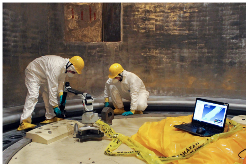
| Obr. 13: 3D měření drážky těsnění dělicí roviny reaktoru |
