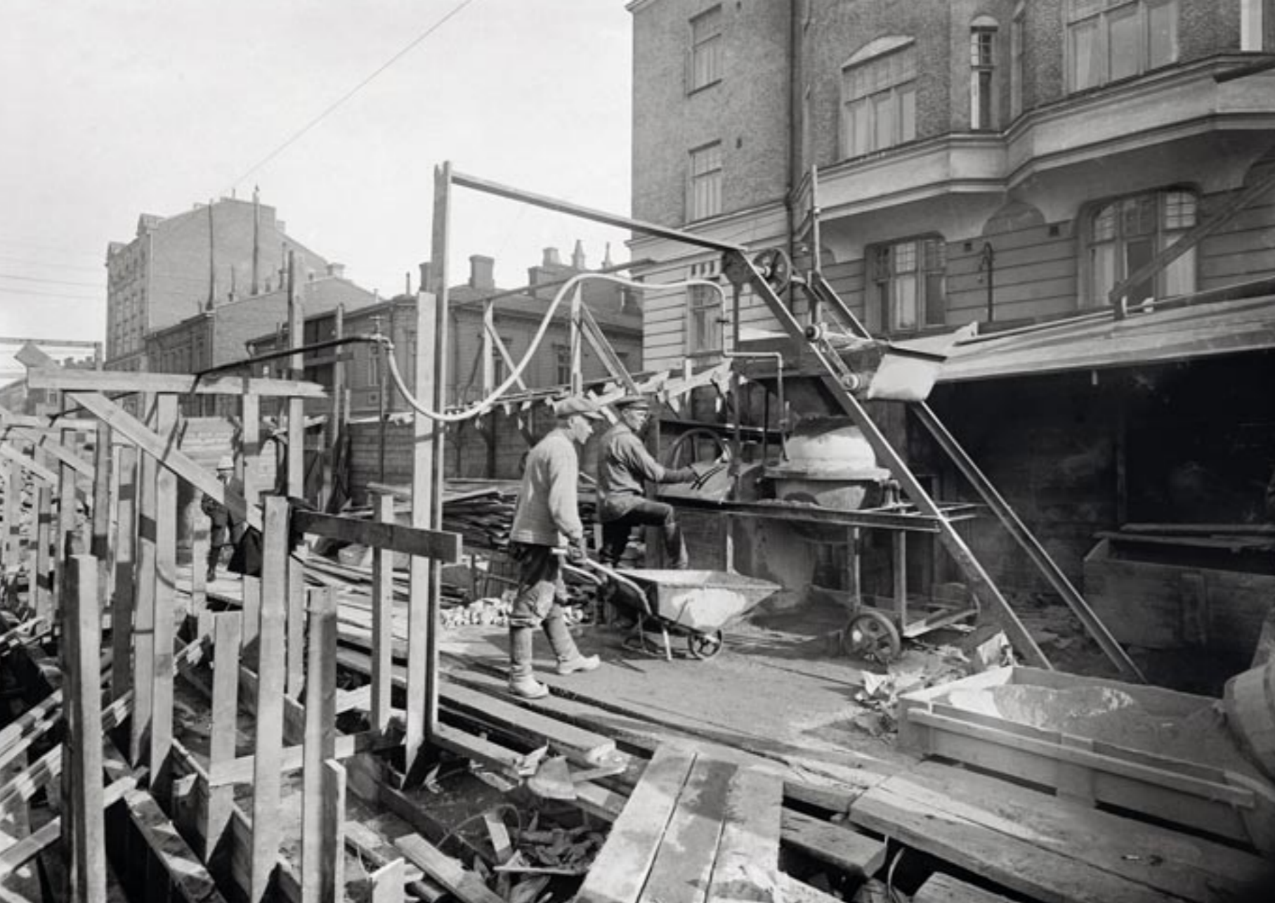
Talonrakennusta Helsingin Fredrikinkadulla 1930-luvulla. Kaupungit kasvoivat voimakkaasti vuosikymmenen alun laman jälkeen, ja uusi kunnallislaki toi kaupungeille uusia velvoitteita. Vuosikymmenen aikana säädettiin mm. lastensuojelu- ja kansaneläkelait.
