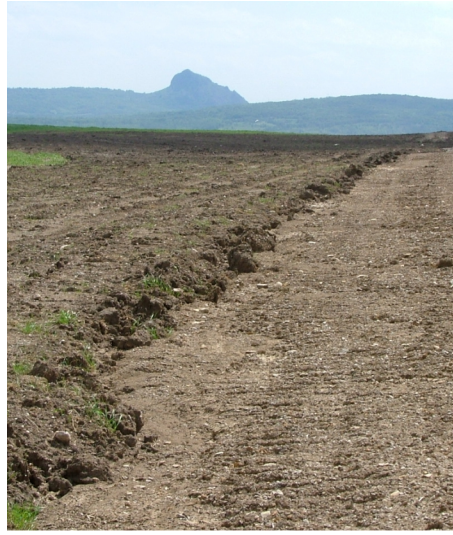
Výsypka Pokrok velkolomu Bílina u Duchcova. Vlevo navršená hlušina, vpravo plocha po technické rekultivaci s právě probíhajícím překrýváním povrchu ornící.
