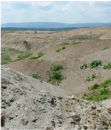
Výsypka Pokrok velkolomu Bílina u Duchcova. Vlevo navršená hlušina, vpravo plocha po technické rekultivaci s právě probíhajícím překrýváním povrchu ornící.
