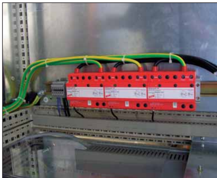
JOONIS 4. DEHNBLOC MAXI KASUTAMINE, KOORDINEERITUD VÄLGUVOOLUKINDEL LIIGPINGEPIIRIK 400/690 V TN-C PAIGALDISTE JAOKS
