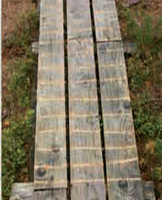
Fot. 2. Nacięcia na powierzchni kładki, wykonane na krytycznych odcinkach, zapobiegają poślizgnięciu. Fot P. Pawlaczyk
