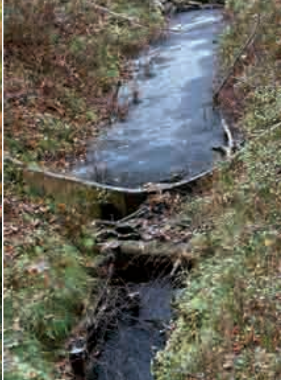
Fot. 2. Prosta zastawka drewniana na torfowisku Bagno Ciemino. Fot. P. Pawlaczyk
