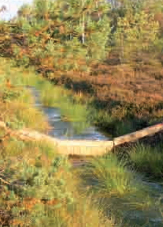
Fot. 1. Zastawka na torfowisku Słowińskie Błota. Fot. P. Pawlaczyk
