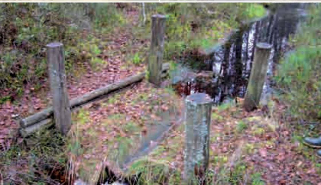
Fot. 3. „Zastawka kartuska” na torfowisku „Kurze Grzędy”. Fot. P. Pawlaczyk
