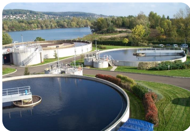
Une station d'épuration
