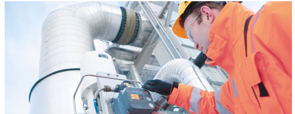
Gigantický závod na zpracování plynu Ormen Lange v Norsku je vybaven systémem 800xA společnosti ABB. Závod dodává prostřednictvím svého podzemního potrubí, které je nejdelší na světě, 20 procent všech dodávek plynu do Velké Británie.
