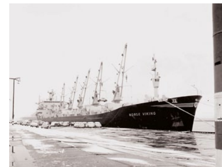
Konec 70. let 20. století Loď „Viking Norse“ vybavená šesti osmitunovými elektrohydraulickými programovatelnými palubními jeřáby.
