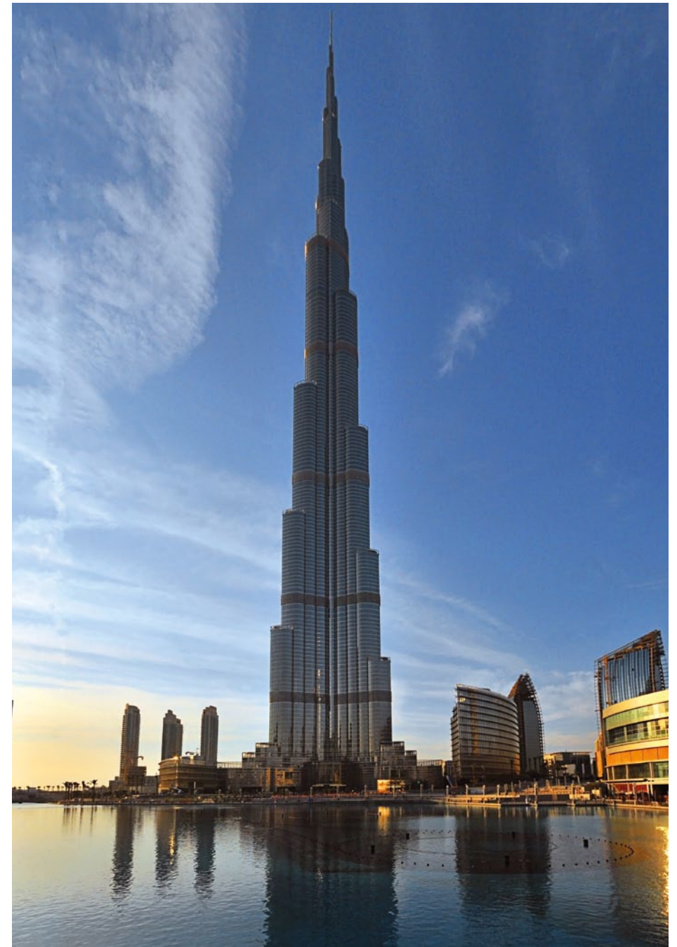
Nejvyšší budova světa, Burj Khalifa v Dubaji, je vybavena transformátory společnosti ABB.
