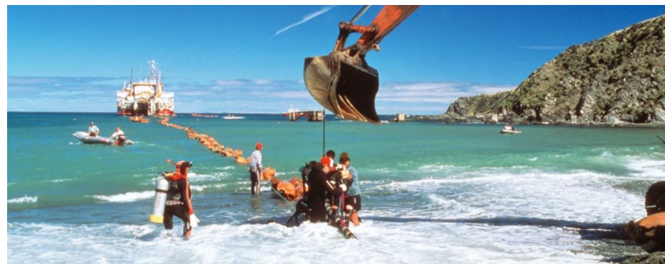
1985 Pokládání kabelů vedení mezi ostrovy na Novém Zélandu přes Cookův průliv. Vedení dodává vodní energii z Jižního ostrova do center poptávky na severu.
