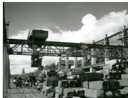
50. léta 20. století Magnetický portálový jeřáb společnosti Asea v závodě Fagersta Bruks AB, Švédsko. Jeřáb má dosah 30 metrů a zvedací nosnost až 12 tun.
