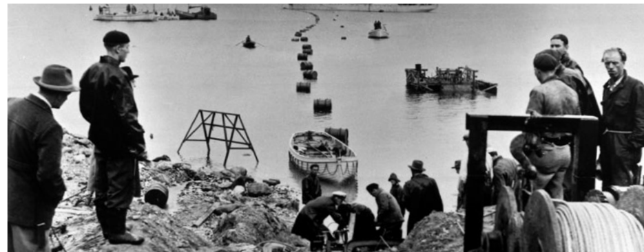
1950 Vytahování gotlandského kabelu na břeh. Elektrické vedení spojilo ostrov s elektrickou sítí švédské pevniny a umožnilo hospodářský rozkvět ostrova.
