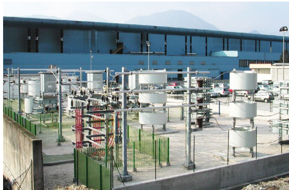
2002 Instalace FACTS v italské ocelárně. Zvýšením kvality elektrické energie v takových závodech může technologie FACTS zvýšit také produktivitu o několik procent.
