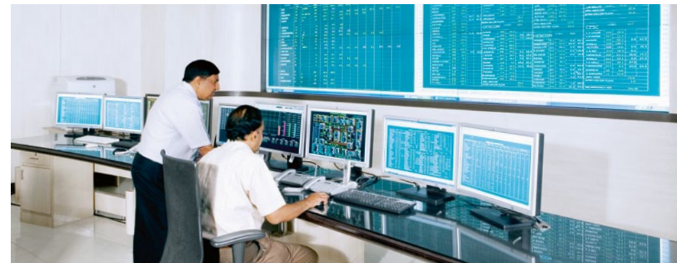
2007–2009 ABB dodalo velín společnosti KPTCL v Bangalore. Systém umožňuje monitorování a řízení celé elektrické rozvodné sítě pro stát Karnataka a zásobuje zde přibližně 16 milionů obyvatel.
