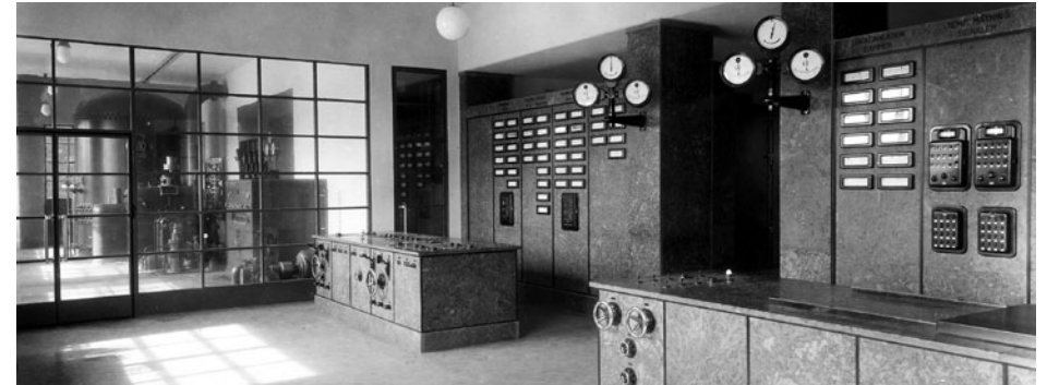
1933 Takto vypadal v roce 1933 velín, odkud se kontrolovala dodávka elektřiny do švédského hlavního města Stockholmu. Místnost je vybavena monitorovacími a řídicími systémy společnosti Asea. Síť zásobovala asi půl milionu obyvatel.
