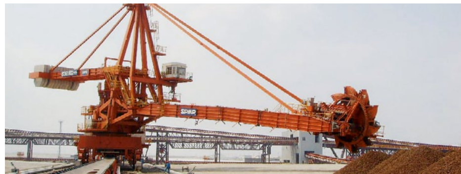
2009 Společnost ABB instalovala automatizované jeřáby v rámci modernizace přístavu Luojing v Šanghaji, největšího překladiště pro volně ložený náklad v Číně. Systémy elektrických jeřábů společnosti ABB jsou tři až čtyřikrát energeticky úspornější než jeřáby poháněné dieselovými motory a neprodukují v místě žádné emise skleníkových plynů.
