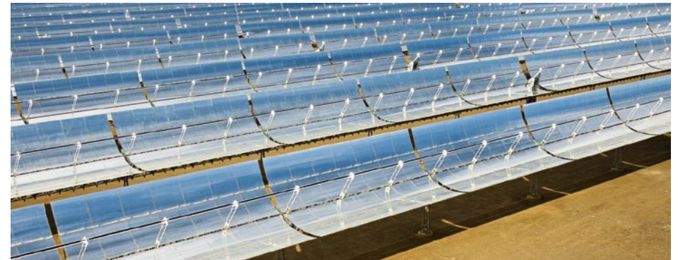
Systém 800xA je využíván k řízení parabolických zrcadel v tepelné solární elektrárně Andasol v jižním Španělsku, která je největší svého druhu v Evropě. Sledování pohybu Slunce po obloze zajišťuje maximální produktivitu.
