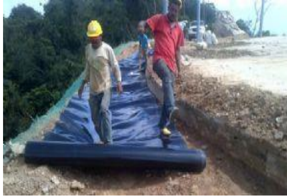
Fotografía 4.8-3 Cuneta en geotextil y/o geomembrana
