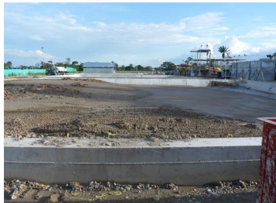
Fotografía 4.8-2 Estabilización de cortes de perforación en piscina
