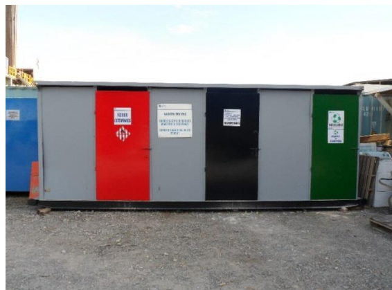
Fotografía 4.8-1 Caseta para el almacenamiento temporal de los residuos
