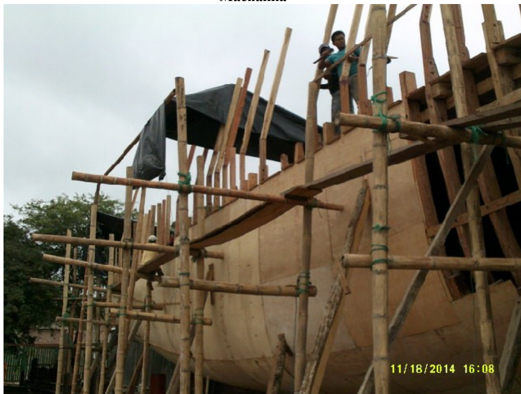
Figura 20.- Set de fotografías que muestran aspectos constructivos de la nave en el astillero en Machalilla
