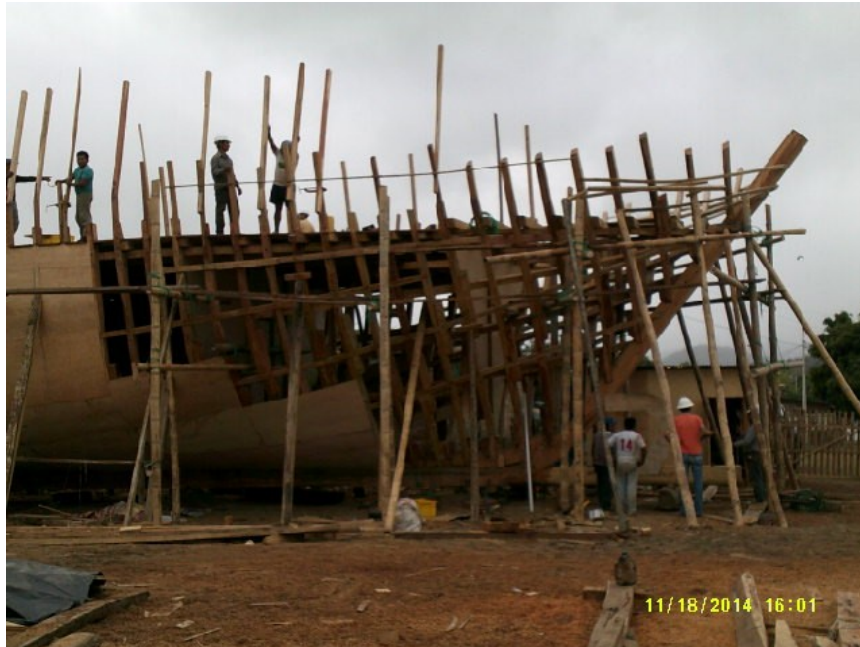
Figura 19.- Set de fotografías del casco con el armado de la estructura y superestructura durante fase de construcción.
