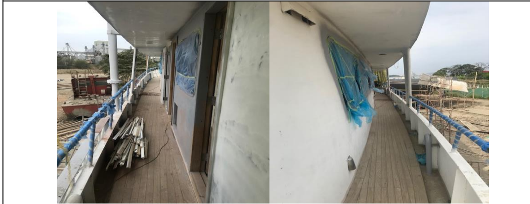
Fotografía 15.- Pasillos (babor y estribor)
