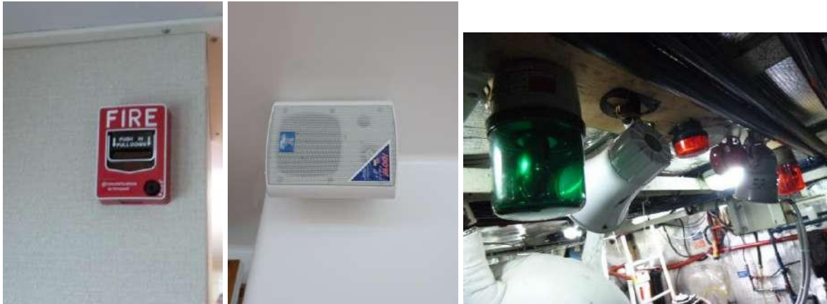
Fotografía 50.- Alarma Sonora – Parlante – Alarmas visuales y sonoras
