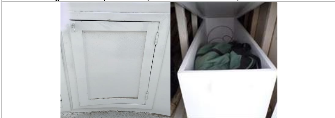
Fotografía 6.- Compartimento para guardar el equipo de combate de incendios (traje de bombero)
