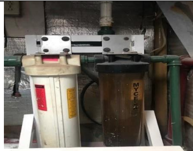
Fotografía 12: La embarcación cuenta a bordo con dos filtros separadores de aguas oleosas.
