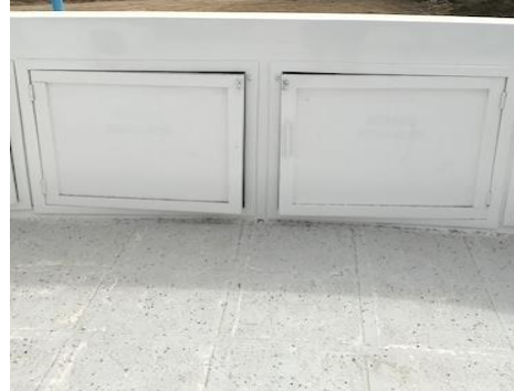
Fotografía 18: Compartimentos para almacenamiento temporal de desechos
