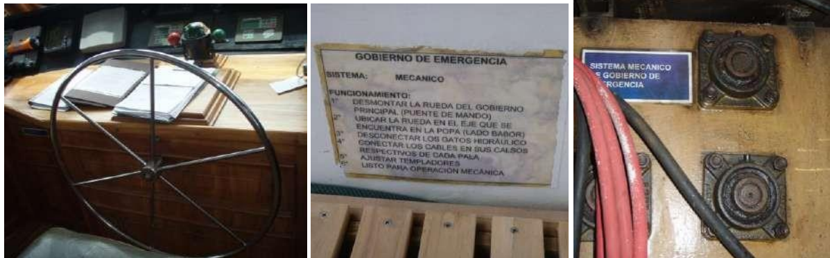
Fotografía 22.- Sistema de gobierno principal – Sistema de gobierno de emergencia
