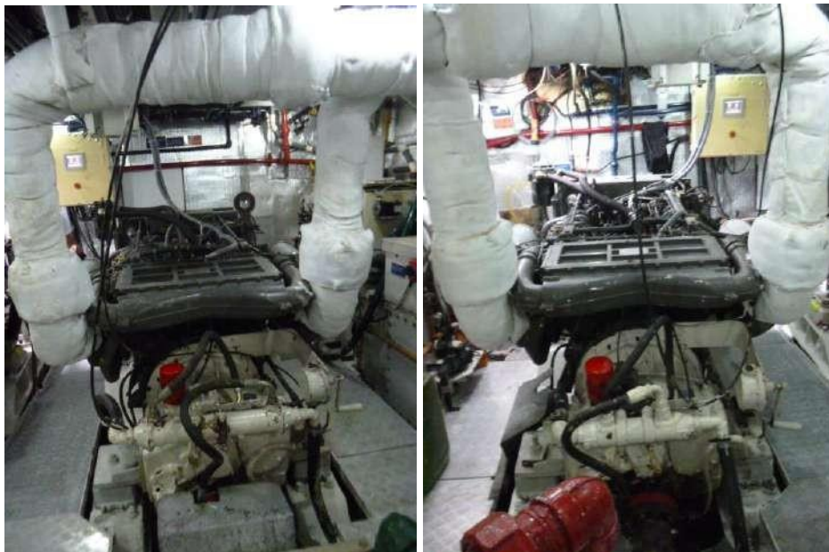
Fotografía 23.- Motores propulsores a babor y estribor
