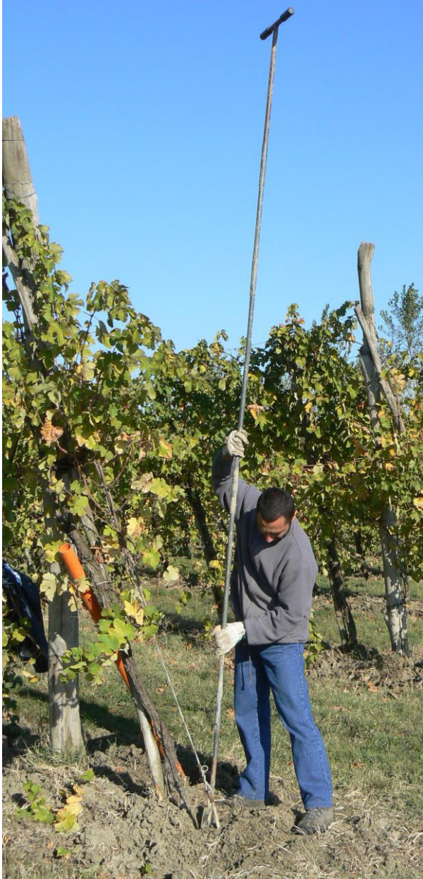
Figura 3. Posa di un tubo mediante l'utilizzo di una trivella di 3 m
