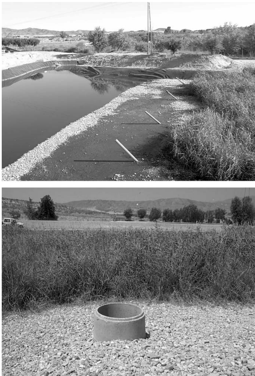
FIG. 5.- Entrada (arriba) y salida del agua (abajo) en el humedal de flujo subsuperficial de Los Gallardos (Almería) (foto: A. Lahora).
