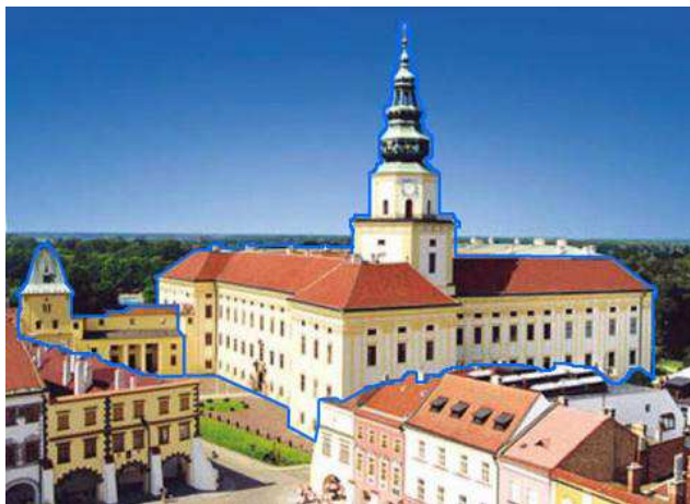
Obr. 1: Identifikace objektu na fotografii
