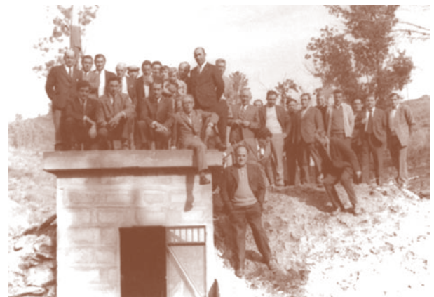
28 de outubro de 1973, inauguración da traída de augas á parroquia de Prado en Pontearreas (Pontevedra). (Foto do arquivo persoal de José M. Pérez)
