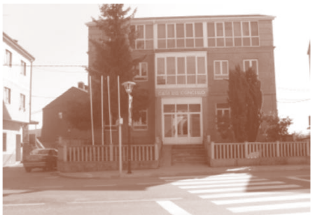
Casa do Concello da Gudiña, en cuxa parte esquerda do baixo instalouse a Axencia. (Autor: José M. Pérez)
