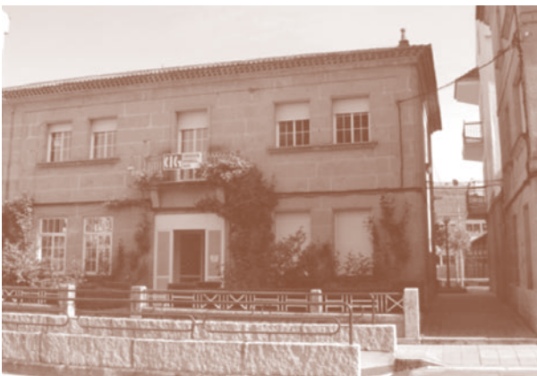
Edificio do patrimonio sindical no que se instalou, case dende un principio a Axencia de Extensión Agraria de Verín (Ourense), que foi reformado con orzamento da Consellería unha vez transferido o SEA á Comunidade Autónoma e recuperado, anos despois, polas organizacións sindicais. (Autor: José M. Pérez)
