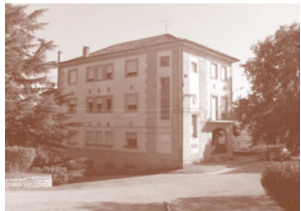
Edificio e predio da escola de capataces de Ourense nunha panorámica tomadas actualmente. (Autor: José M. Pérez)
