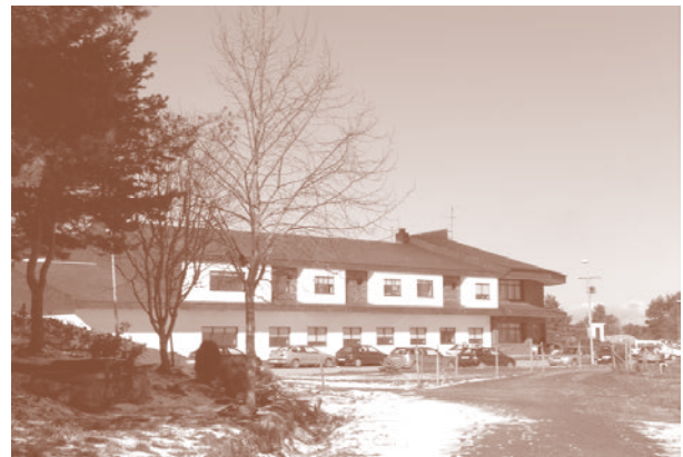
Fachada principal do Centro de Formación e Experimentación Agroforestal de Becerreá. (Foto do arquivo do centro)
