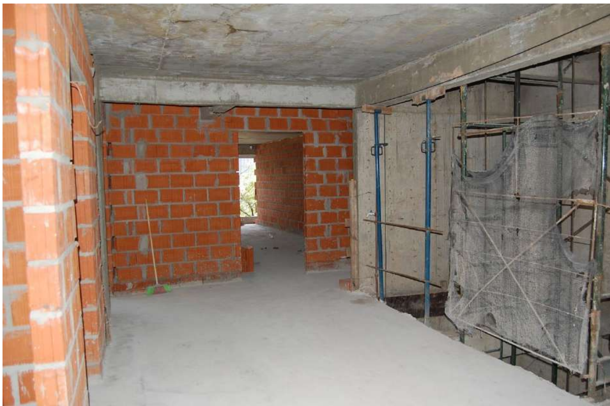
2ºP – MAMPOSTERÍAS, CONTRAPISOS Y CARPETAS EJECUTADAS
