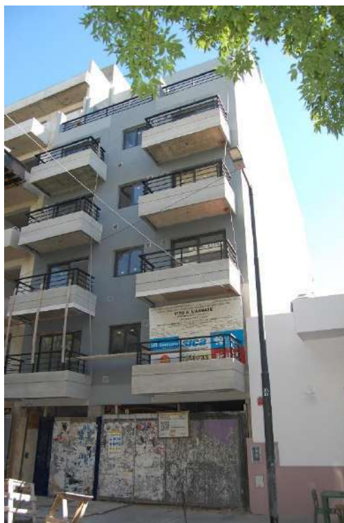
VISTA DEL FRENTE DE LA OBRA
