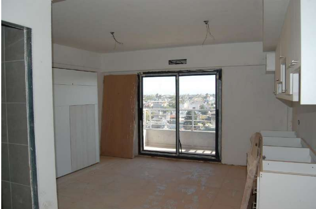
VISTA DE ESTADO DE TERMINACIÓN DE UNIDAD PISO 8°
