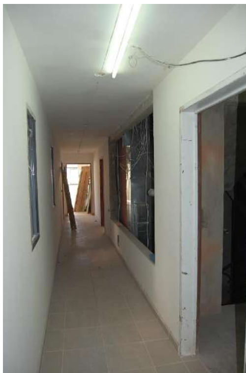
VISTA ESTADO EJECUCIÓN PALIER PISO 2°
