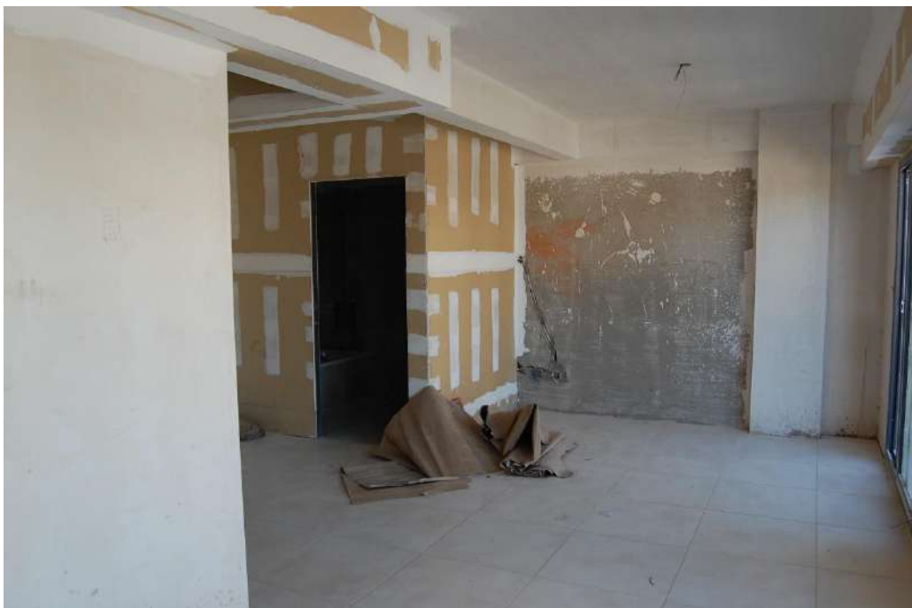
VISTA ESTRUCTURA DE DURLOCK EN PB
