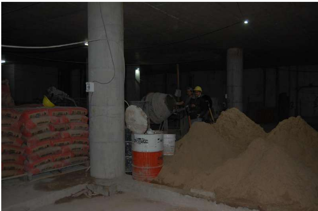
CANCHA PARA LA PREPARACIÓN DE CONTRAPISOS EN PB
