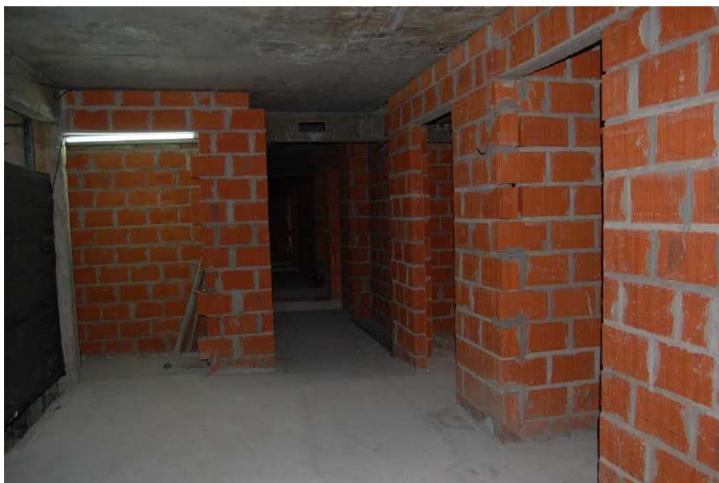
2ºP – MAMPOSTERÍAS, CONTRAPISOS Y CARPETAS EJECUTADAS
