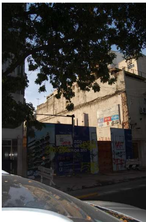
VISTA DEL FRENTE DE LA OBRA DESDE LA CALLE
