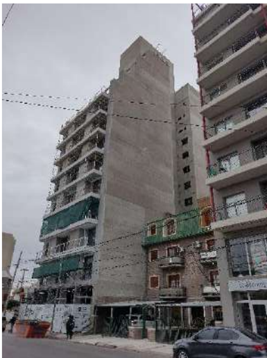
Frente actual s/Calle I. Malvinas
