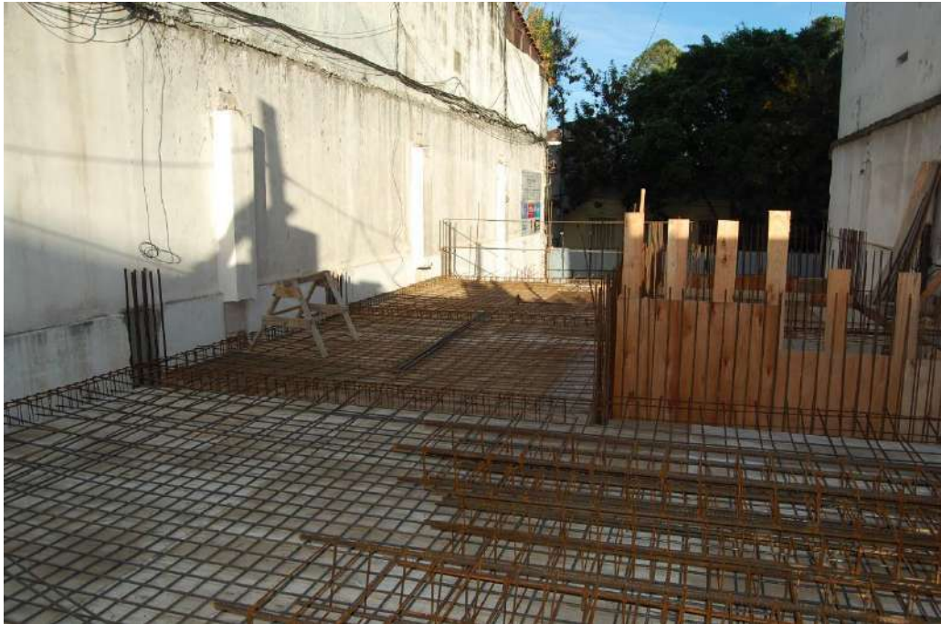
SECTOR DE LOSA s/PB CON ARMADURA COMPLETA
