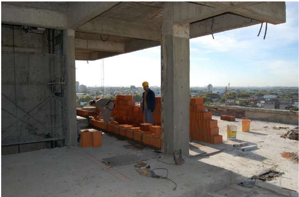
PISO 9° - INICIO DE CIERRE DE MEDIANERAS
