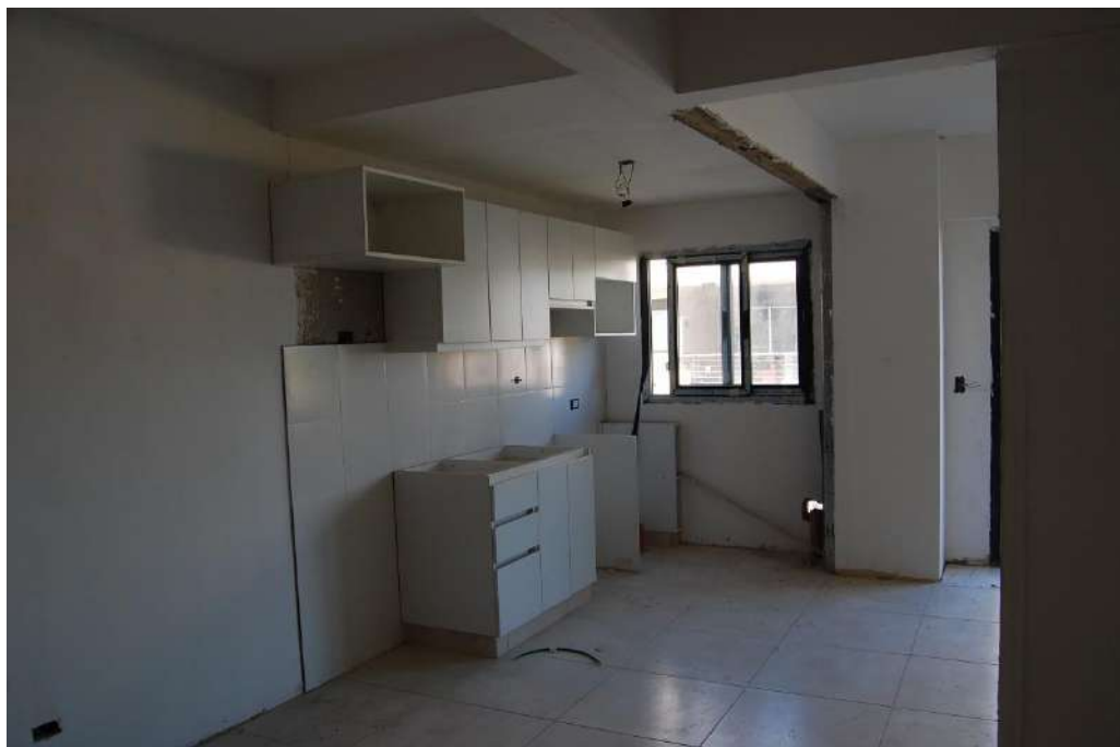
VISTA ESTADO EJECUCIÓN UNIDAD PISO 4°
