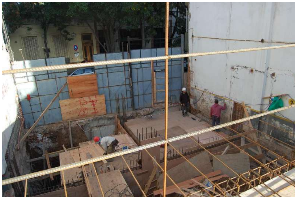
SECTOR DEL FRENTE DONDE SE EJECUTA ESTRUCTURA SET
