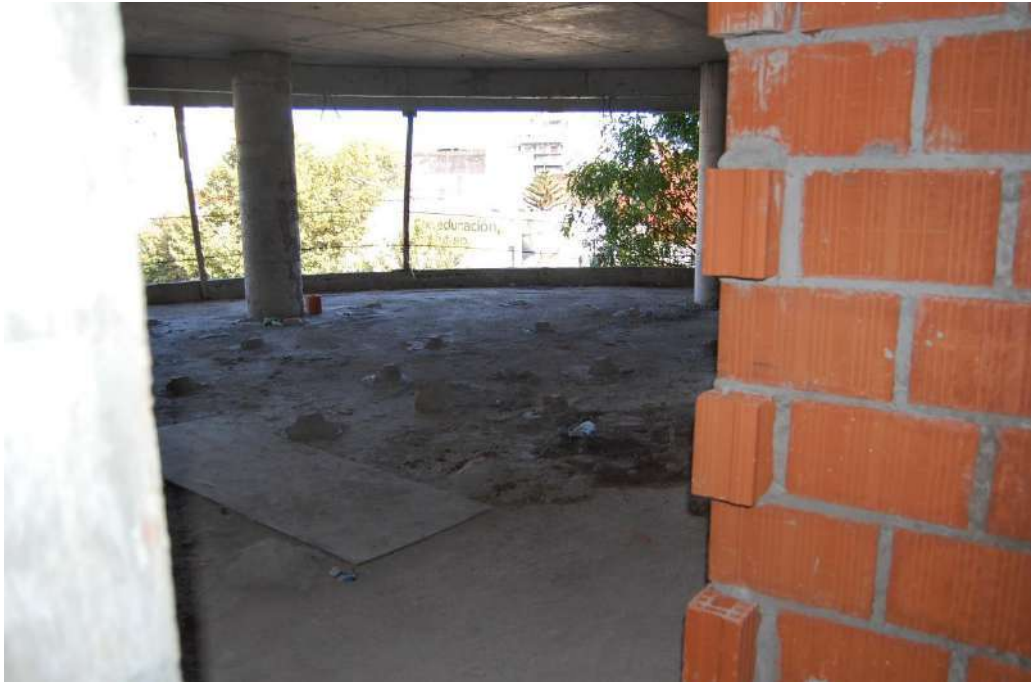
PISO 4° - PREPARACIÓN DE TACOS PARA NIVELAR CONTRAPISO Y CARPETA
