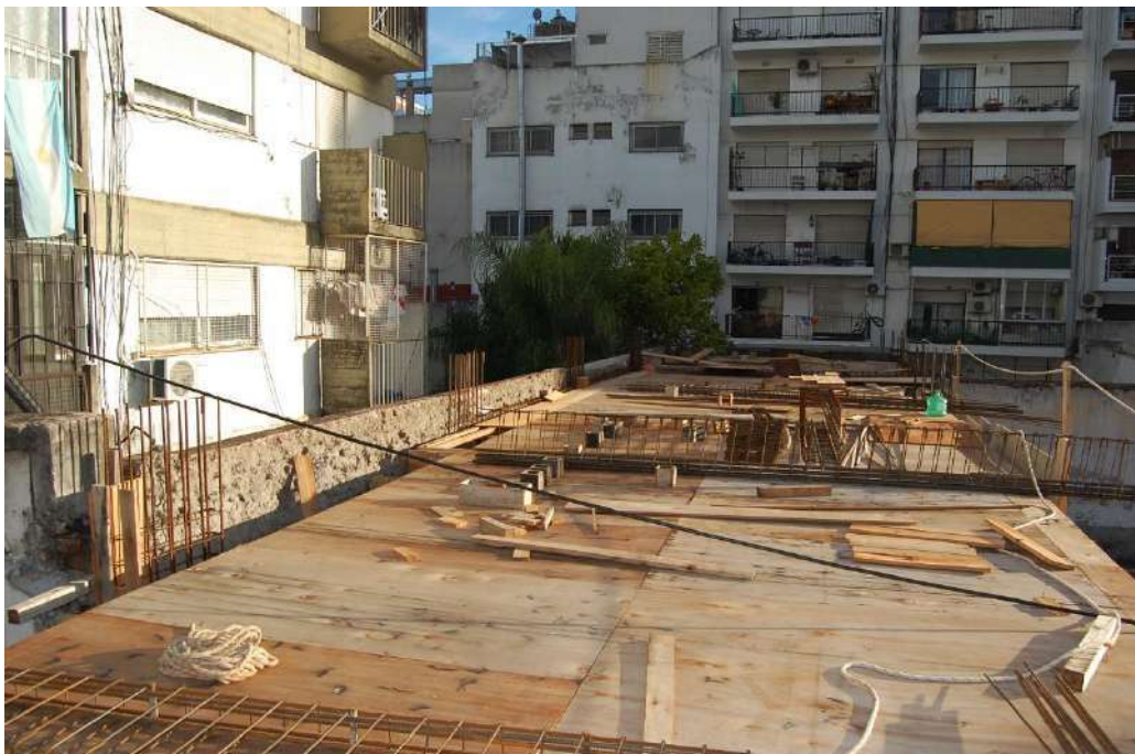
SECTOR FONDO – LOSA S/1ºP ENCOFRADA CON ARMADURA PARCIAL
