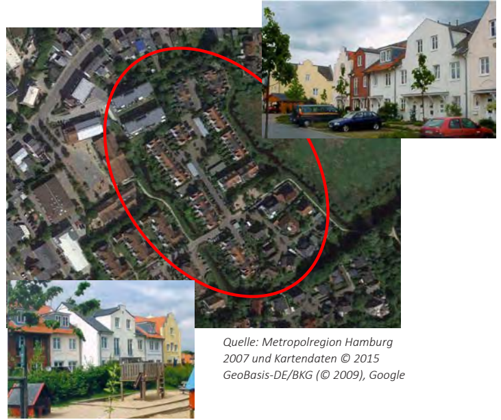
Abb. 57 Elmshorn „Am Fischteich“: 40 WE/ha 63 Reihenhäuser auf rund 1,56 ha
