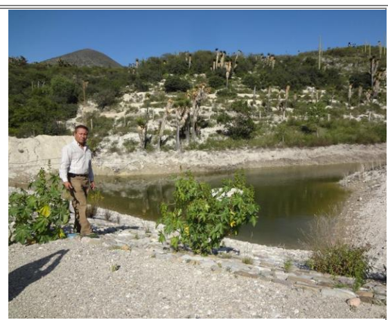
Diputado Lic. Sergio Gómez Olivier en visita de inspección a la represa de tierra compactada.
