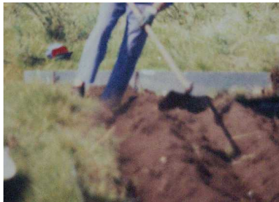
Foto 26 Esta foto amosa o recubrimento con solo do rego aberto, e ó mesmo tempo temos unha visión do derradeiro rego é a súa adaptación á parcela 663
