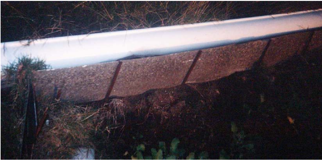
Foto 15 Canle de 210 mm e banda lateral de 300 mm instaladas para evacua-las escoas superficiais e subsuperficiais ás parcelas
