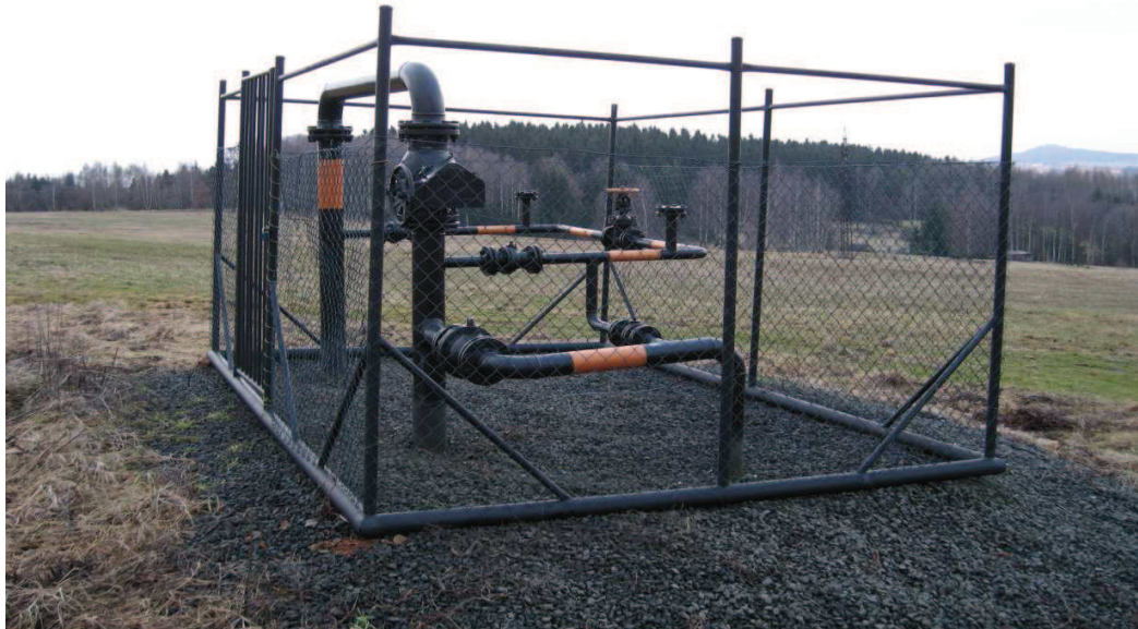
Obrázek č. 4: Trasový uzávěr v zemním provedení bez obtoku – používá se zpravidla u dimenzí do 150 mm
