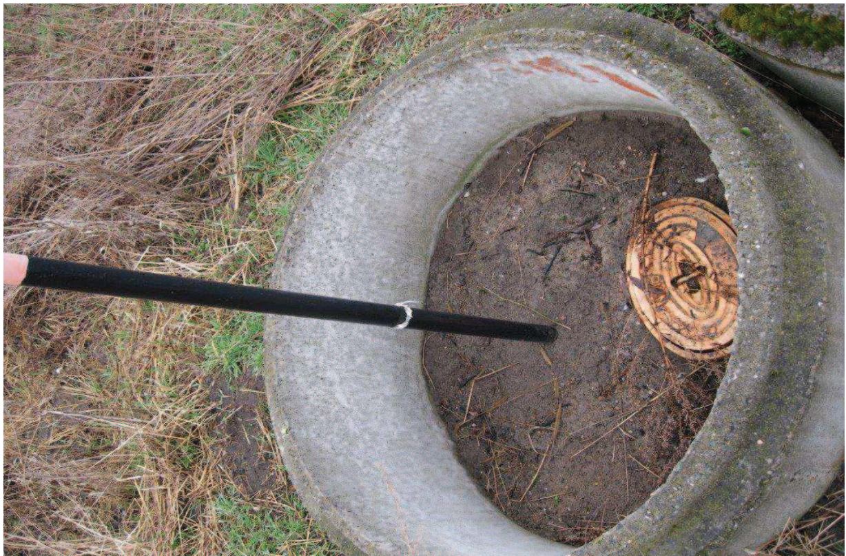
Obrázek č. 4: Trasový uzávěr v zemním provedení bez obtoku – používá se zpravidla u dimenzí do 150 mm
