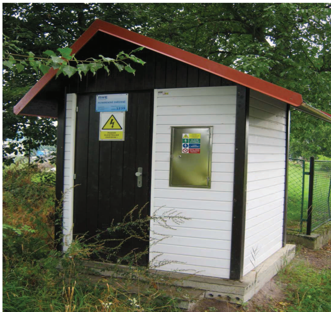
Obrázek č. 5: Objekt budovy stanice katodické ochrany
