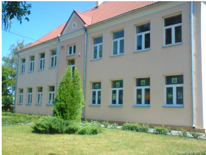
Fotografia 2 Budynek Szkoły Podstawowej w Przywieczerzynie
