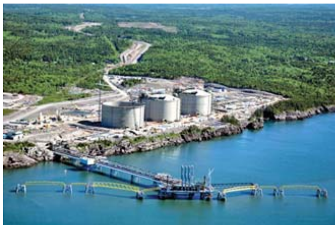
Canaport LNG Terminal
