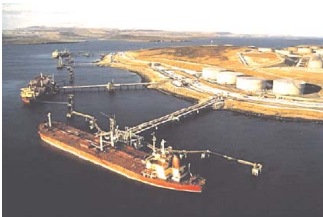
Sullom Voe Terminal
