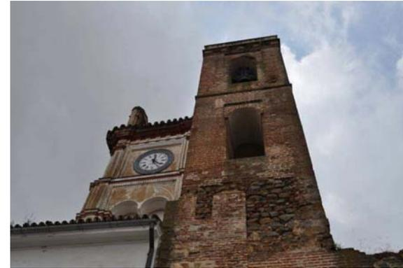
Figura 6.14. Detalle de la torre gótico-mudéjar construida sobre las almenas, de la ampliación correspondiente a la fase 2.
