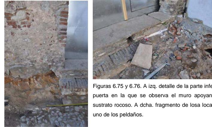
Figuras 6.75 y 6.76. A izq. detalle de la parte inferior de la puerta en la que se observa el muro apoyando en el sustrato rocoso. A dcha. fragmento de losa localizado en uno de los peldaños.
