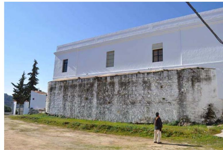
Figura 6.9. Vista del muro de cierre oeste del edificio en el que se encuentra la estructura previa, realizada con mampostería.
