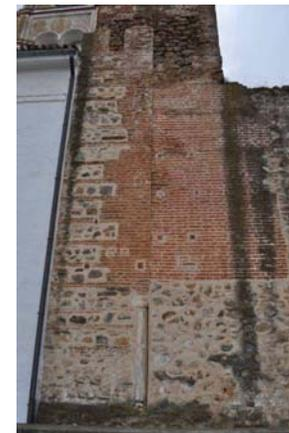
central, en la cual se prolonga la planta de la fábrica primitiva (Fase 2, figs. 6.12 y 6.16). A este segundo momento corresponden los paramentos en los que se abren los accesos actuales al edificio, aunque los vanos de esta reforma mudéjar se encuentran cegados, como puede observarse en la nave de la epístola.
