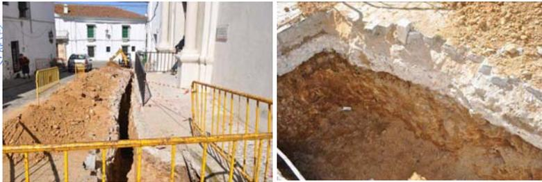
Figuras 6.79 y 6.80. Vista general y detalle de la zanja abierta en la calle San Francisco para la introducción de infraestructuras.
