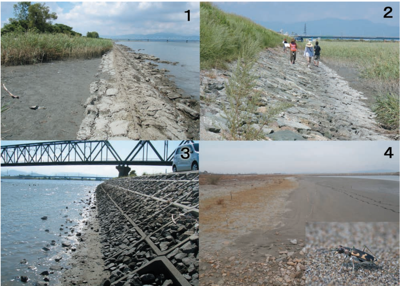
図10. 吉野川河口域のエコトーン. 1, St. 6における昔の石積み護岸と背後に形成された干潟とヨシ原; 2, St. 10における堤防の昔の石積み護岸と護岸の際の泥干潟・ヨシ原; 3, St. 2における護岸改修後に石積み護岸の環境を復元したと考えられる護岸; 4, 河口南岸の沖洲海岸の沖を埋めて造成されたライスハンミョウ保護のための人工海浜.
