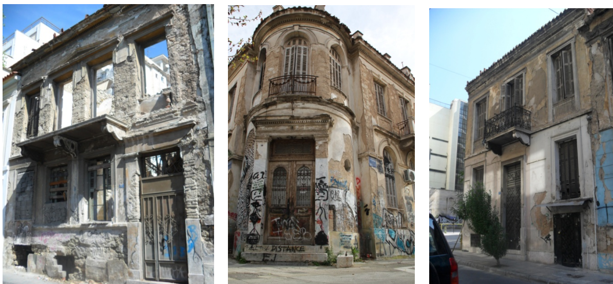
Εικόνες 14-15-16 : Εγκαταλελειμένα κτίρια στο Μεταξουργείο
