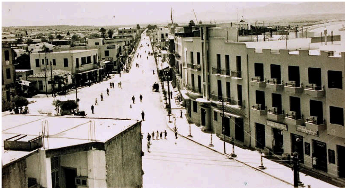
Εικόνα 3, 4. Ιστορικές φωτογραφίες της πόλης του Λουτρακίου, όπου φαίνεται η ανάπτυξή της εκ της χρήσης των ιαματικών λουτρών
