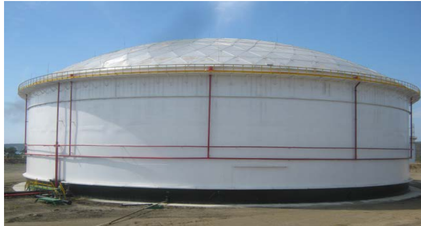
Figura 7: Tanque con domo geodésico.
