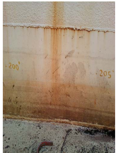
Fig. 14 Estacionado del en el centro del tanque
