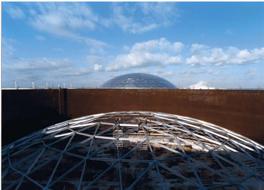
Figura 8: Construcción del domo en el interior del tanque
