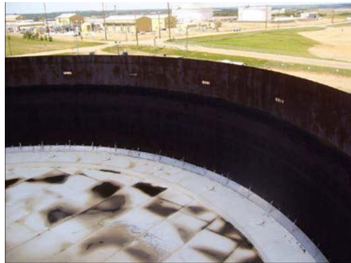
Figura 3: Techo flotante tipo pontón
