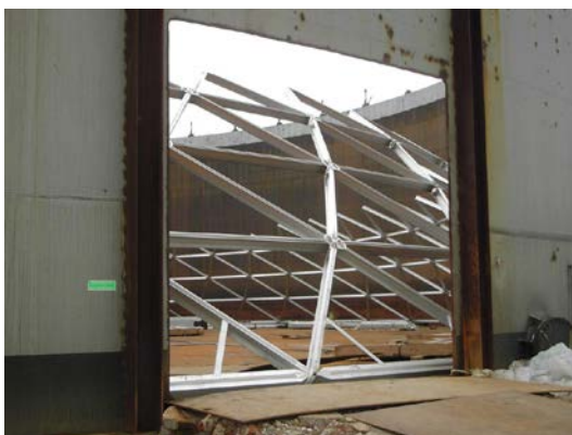
Figuras: 5 y 6 Montaje de la cúpula desde el interior del tanque
