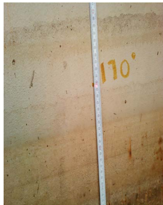
Figuras. 17 y 18 Replanteo de los puntos cada 5° en el rolo base a un pie de altura (30cm) del fondo del tanque.
