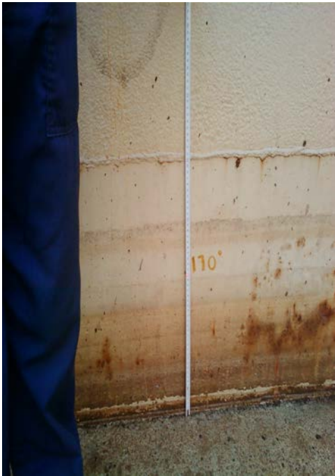
Figuras. 17 y 18 Replanteo de los puntos cada 5° en el rolo base a un pie de altura (30cm) del fondo del tanque.
