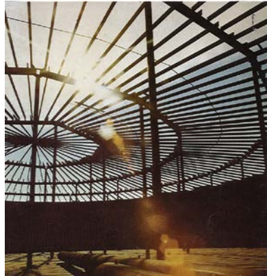
Figura 2: Imagen del interior de un tanque de techo fijo.
