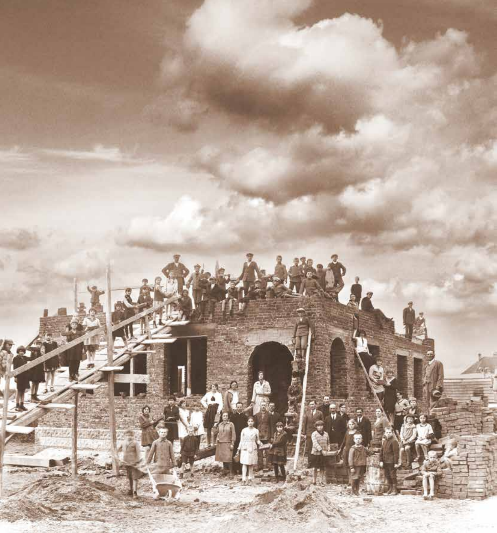
Dzieci i dorośli na placu budowy ochronki, 1931 r.
