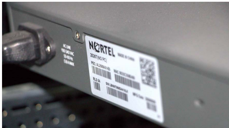
Imagen 204: Equipo Nortel en la sala
