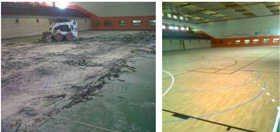
Figura 12. Obras de remodelación de suelo de pista y resultado
