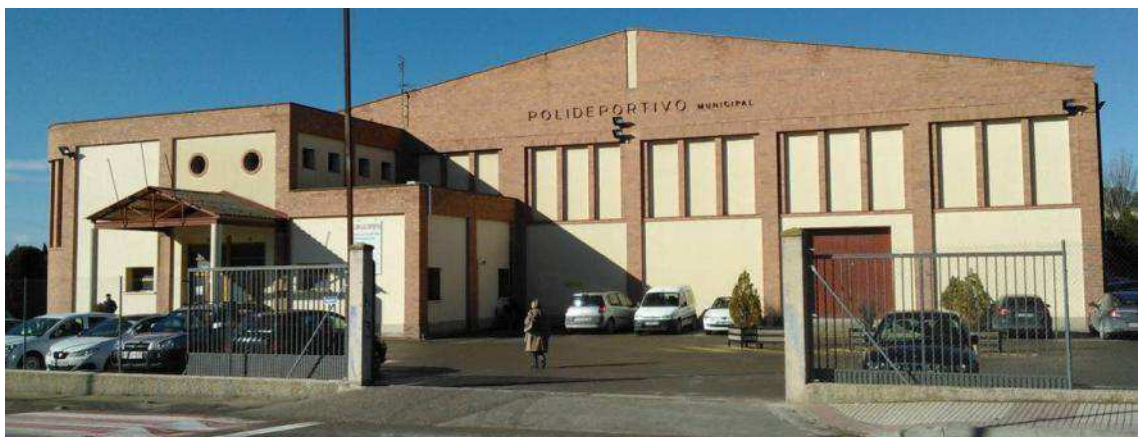
Figura 3. Vista exterior del polideportivo municipal de Tauste
