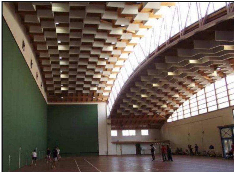
Figura 71. Imágenes de recinto con material fonoabsorbente
