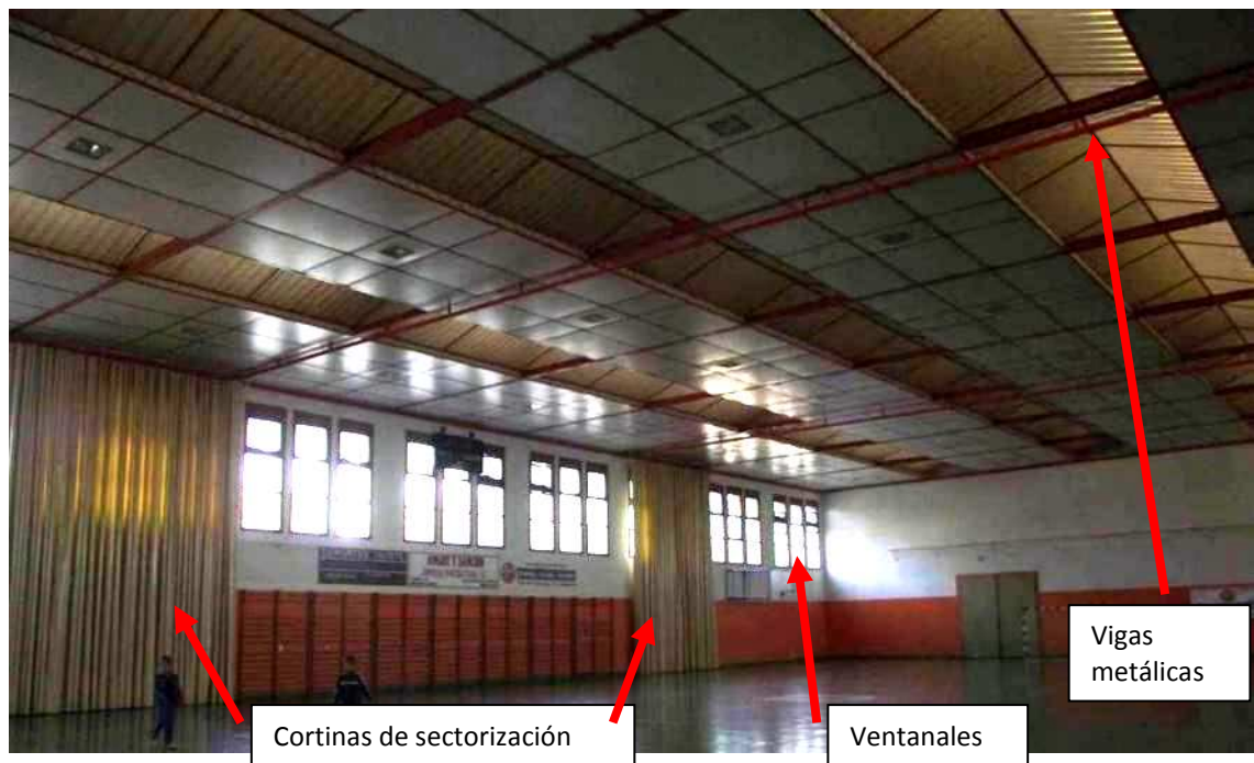
Figura 14. Vista interior del polideportivo municipal de Tauste
