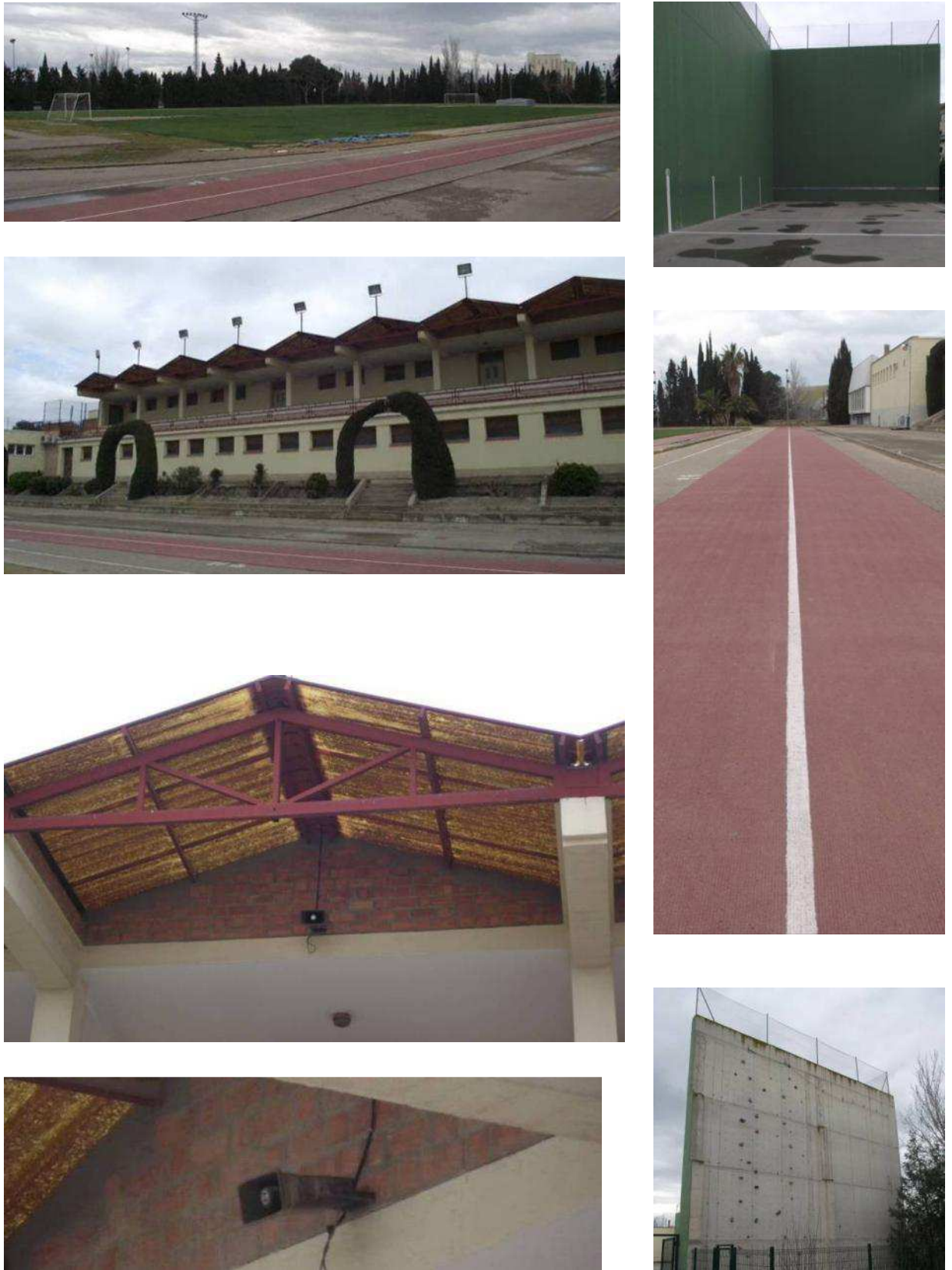
Figura 7. Vista de instalaciones anexas exteriores
