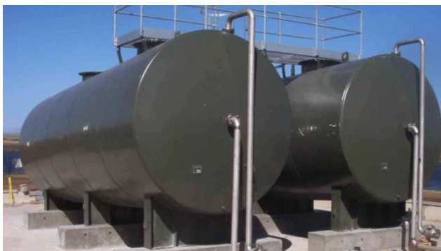
Figura 3: Depósito cilíndrico horizontal, fondo
