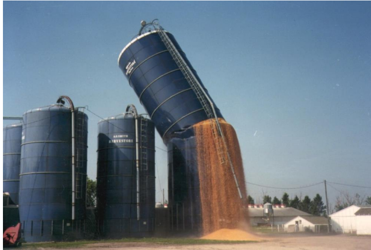
Figura 7: Fallo por dimensionamiento incorrecto
