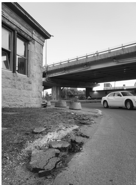
Vue actuelle sur le virage de la Riverside, au coin de la station de pompage.
