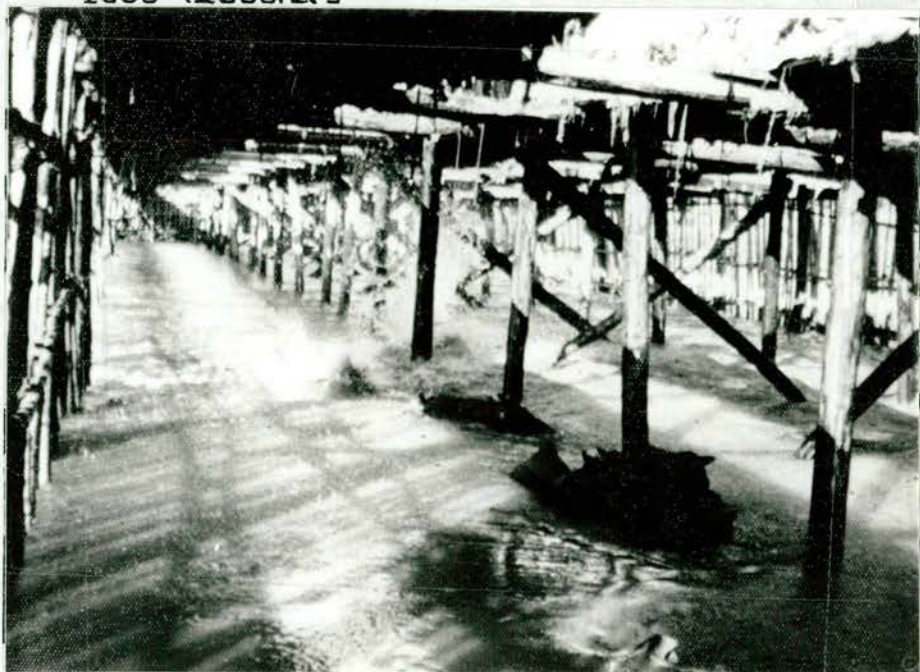
Actual closure in progress
